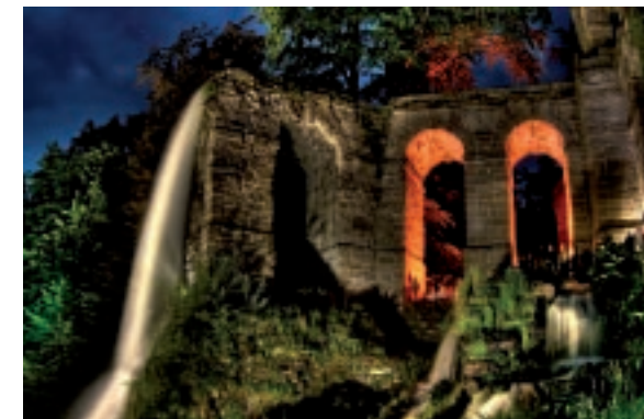
Das Aquädukt im Bergpark Wilhelmshöhe. Foto: R. Kaufhold
